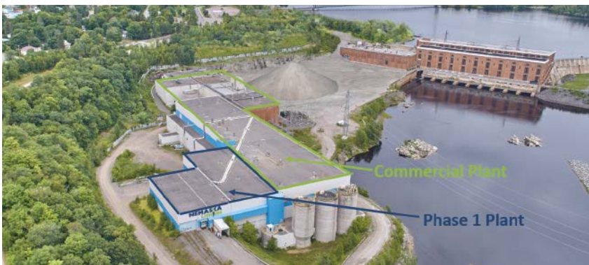
In dem Gebäude, das Nemaska zu 100% gehört, wird aktuell an der Phase 1 der zukünftigen Verarbeitungsanlage gearbeitet.
