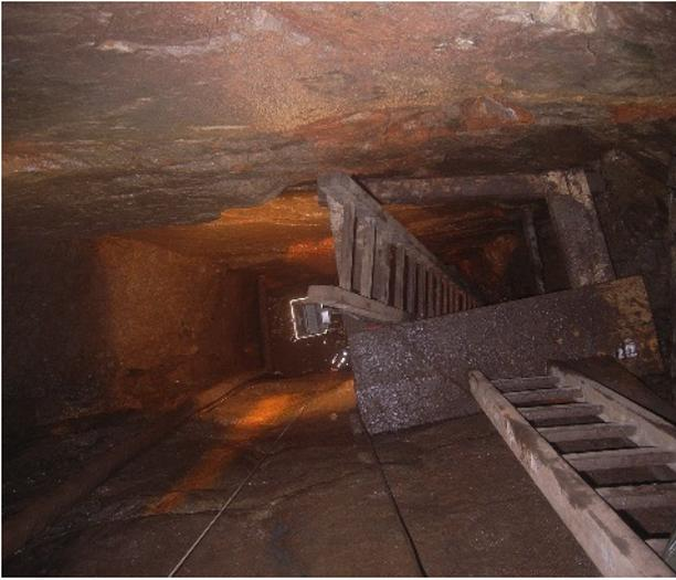
Abb. 8 Blick in den saiger abgeteuften Schacht des 2. Gesenks mit Zwischenbühne zur Aufnahme der Fahrt (Leiter).
