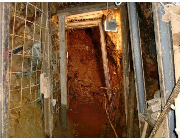
Abb. 7 Ortsbrüst der 1. Sohle ca. 20 m nordwestlich des 3. Gesenks. Das Foto markiert das Ende der Sanierungsarbeit von 2012. Hinter den Verbruchmassen verläuft die 1. Sohle wahrscheinlich noch 75 m bis 79 m weiter nach NW bis zur ursprünglichen Ortsbrüst von 1669/70.
