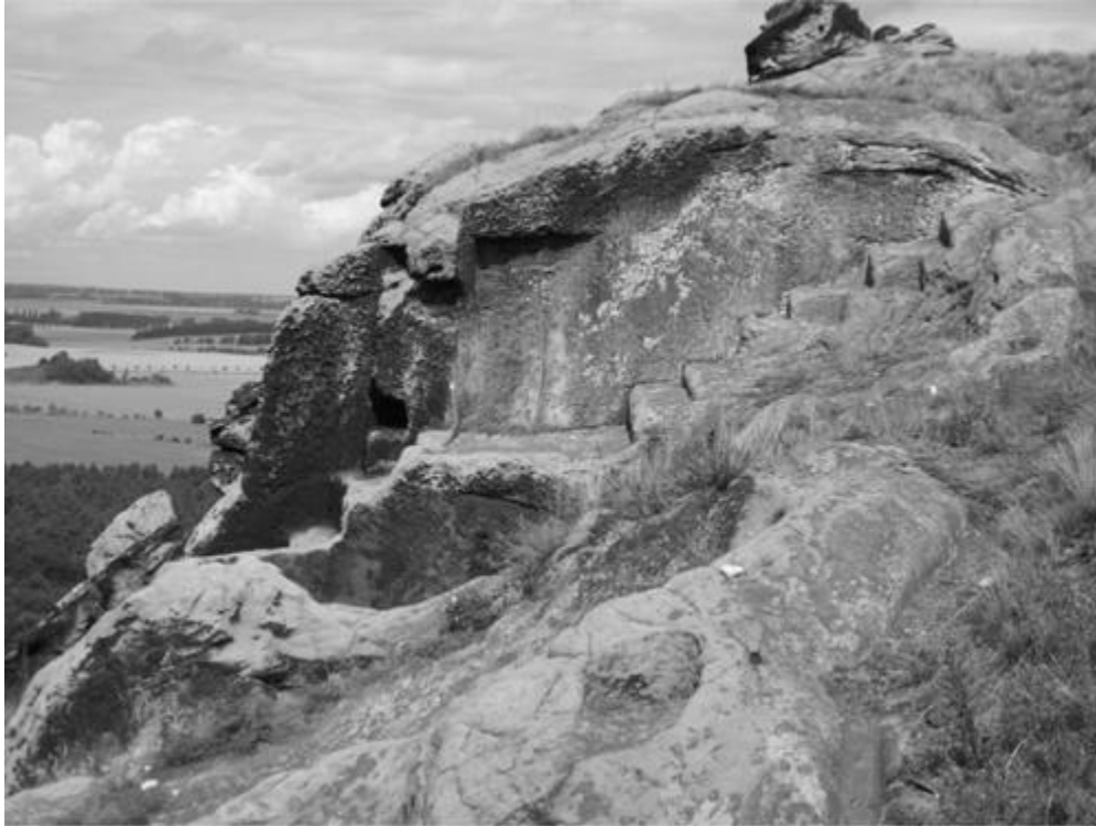
Abb. 27: Festung Regenstein bei Blankenburg: Als ob ganze Stücke im Fels fehlen, führen Steintreppen scheinbar in den Abgrund. Foto: Roth
