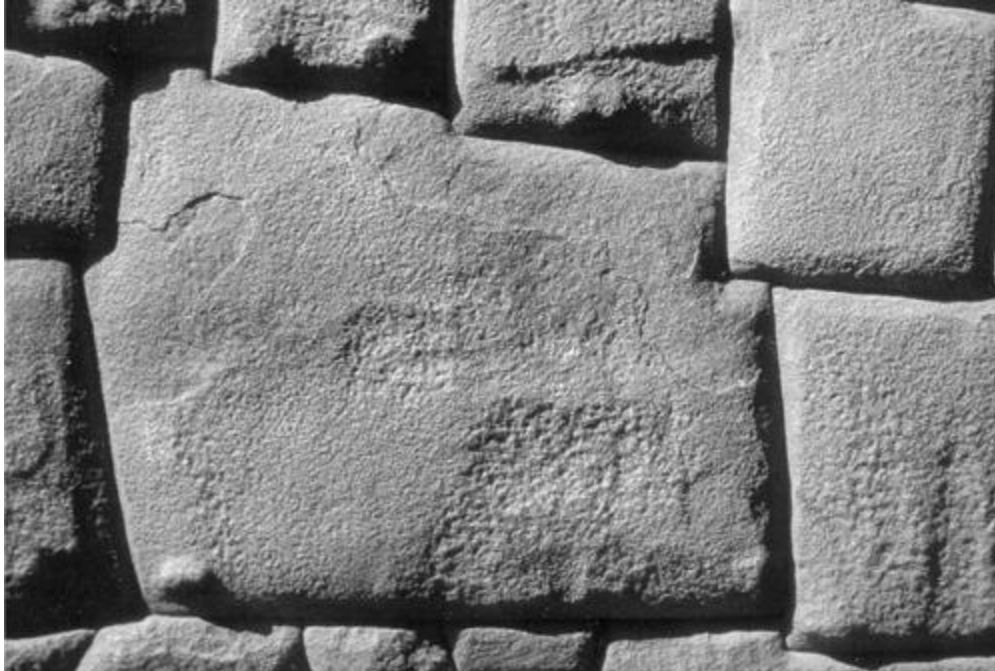
Abb. 34: Der sog. Stein der zwölf Engel. Ein berühmtes Meisterwerk der Steinmetzkunst, das immer noch in der Hatun-Raumiyoq-Straße in Cuzco steht. Die Steine dieser Mauer passen so perfekt, dass keinerlei Mörtel erforderlich war. Heute ist diese Mauer Teil des Palastes des Erzbischofs von Cuzco, einst war das der Königspalast des Inka Roca. Erbauer unbekannt. Foto: Ronald Rattmann
