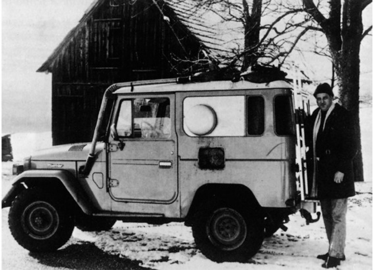
Holzvergaserautos müssen nicht wie Monster aussehen: Beispiel eines privaten Umbaus aus den siebziger Jahren. Alle Bauteile gefällig integriert. [19]
