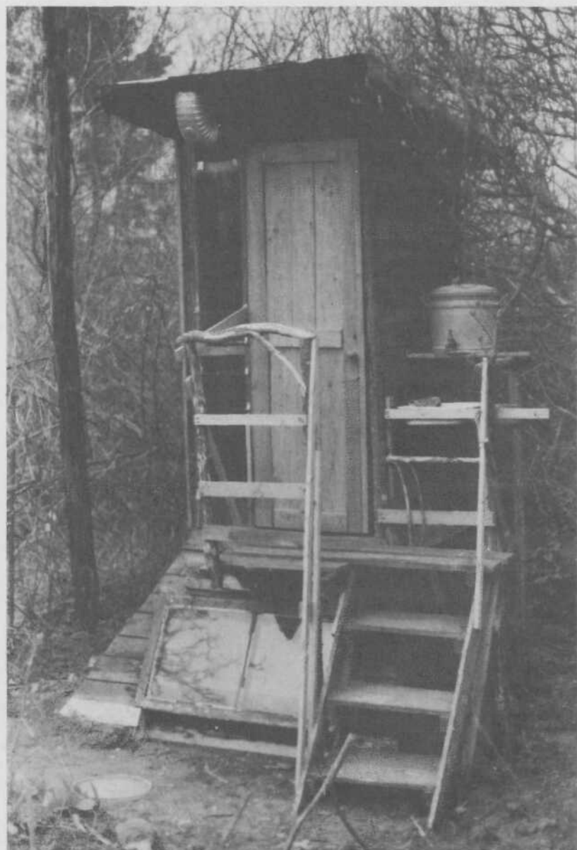
Großes Kompostklo mit „Luxus“: rechts Handwasch- becken und regenwasser-gefüllter Wassertank. Links neben der Treppe die Luftvorwärmung hinterm Fenster, neben der Tür das Durchlüftungsrohr mit Zugverstärkung durch Sonnenwärme.
