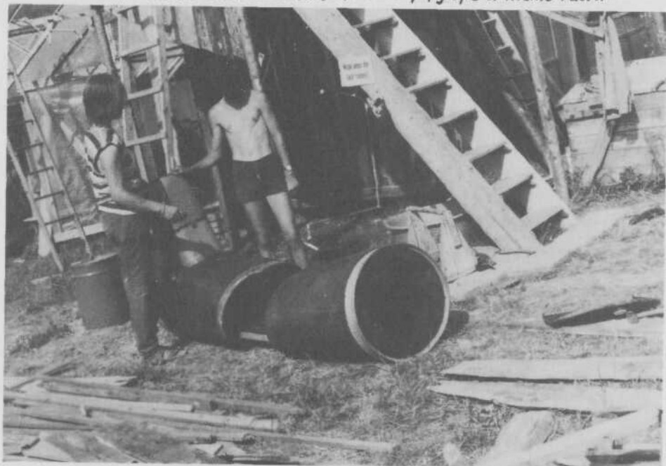
Beim Zusammenbau des Behälters. Links: angesetzter Schacht, rechts: Loch f. Klappe.
