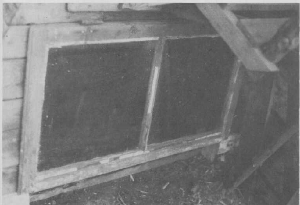
Das Fenster der Solar-Luftvorwärmung ist davorgestellt.
