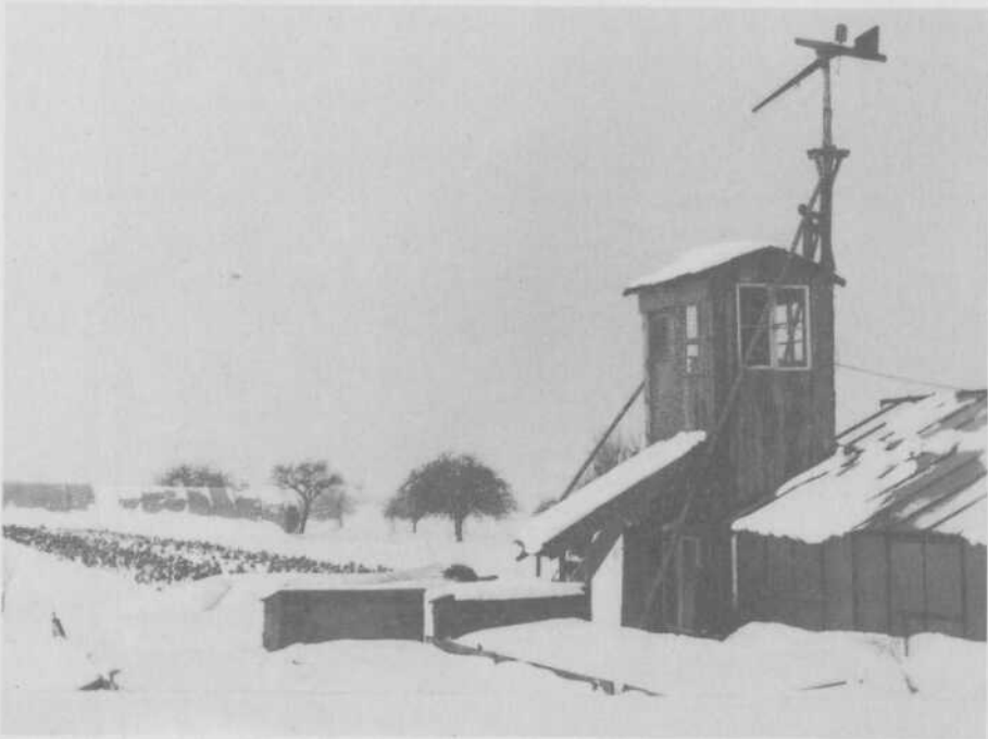
Kompostklo-Sonnenkollektor-Windrad-Turm fertig am Gewächshaus, erster Winter
